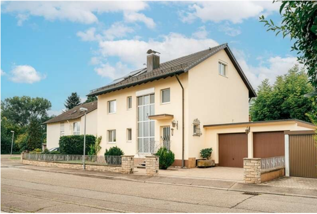
ANSICHT VON DER STRASSE!
